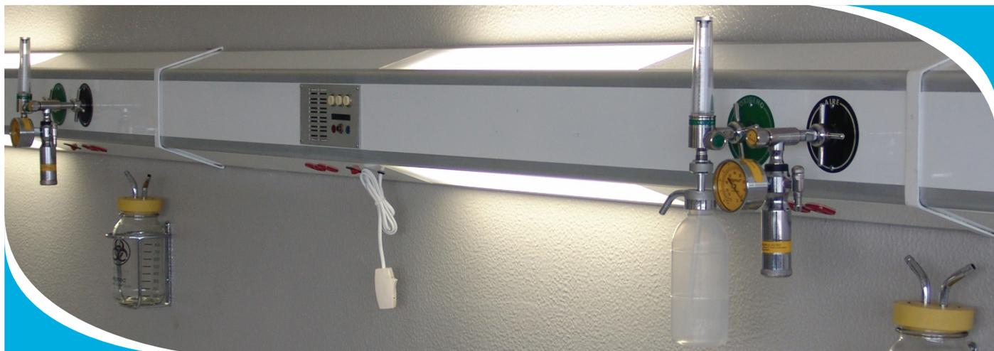
Consola para encamados tipo horizontal, fabricada en aluminio de extrusión especial 6063 temple 5, anodizado natural a 10 micras de oxidación, con espesor mínimo del perfil de 3 milímetros.
